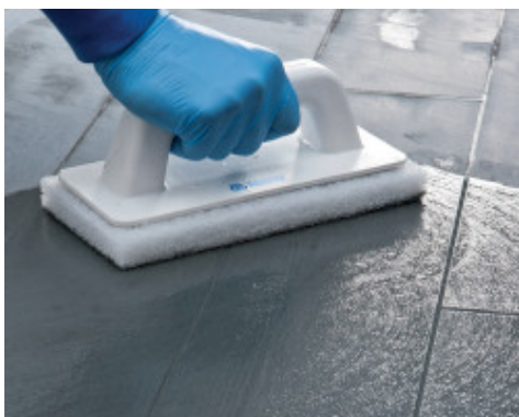
Czyszczenie spoin za pomocą pacy typu Scotch-Brite® (spoina częściowo utwardzona)
