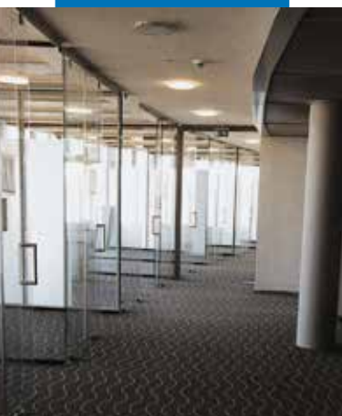
Montaż wykładziny dywanowej z użyciem Ultrabond Eco Fix. Post Tower - Włochy
