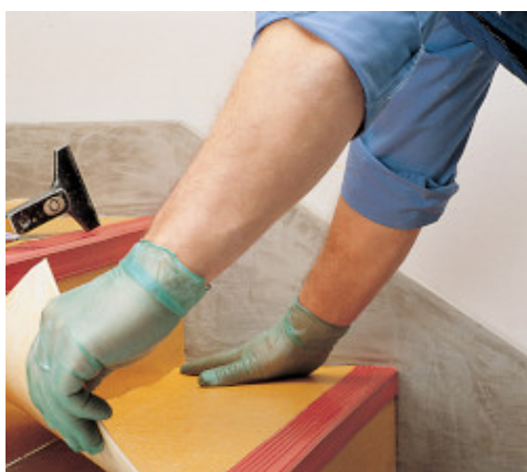
Montaż wykładziny PVC na schodach
