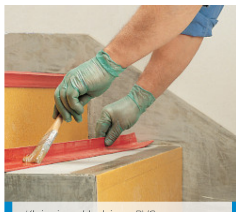
Klejenie wykładziny z PVC na schodach
