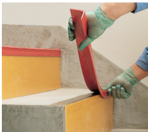
Montaż zwisu stopnia z PVC
