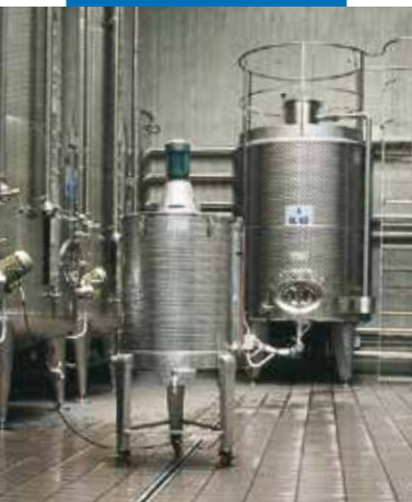
Przykład posadzki w zakładach winiarskich
