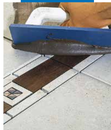
Spoinowanie posadzki ceramicznej z elementami drewnianymi przy użyciu pacy MAPEI
