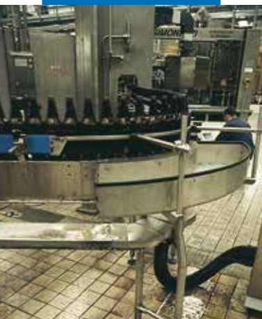
Przykład posadzki w browarze, zaspoinowanej z użyciem Kerapoxy
