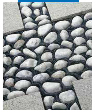
Spoinowanie dekoracyjnej posadzki kamiennej
