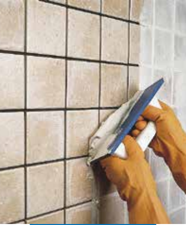
Spoinowanie płytek glazurowanych
