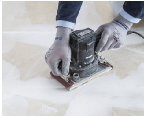
Szlifowanie powierzchni wyrównanej z użyciem Planiprep 4 LVT
