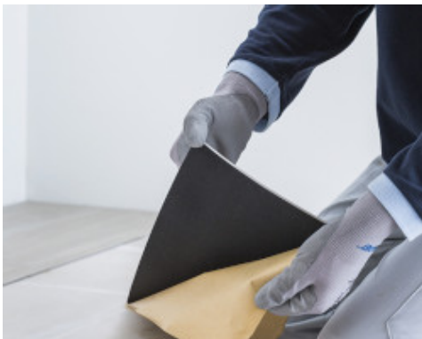
Usuwanie folii ochronnej z samoprzylepnego panela LVT
