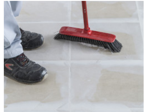
Usuwanie pyłu po szlifowaniu
