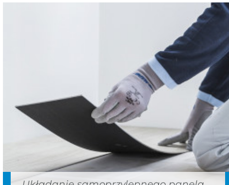
Układanie samoprzylepnego panela LVT na posadzce ceramicznej wyrównanej z użyciem Planiprep 4 LVT
