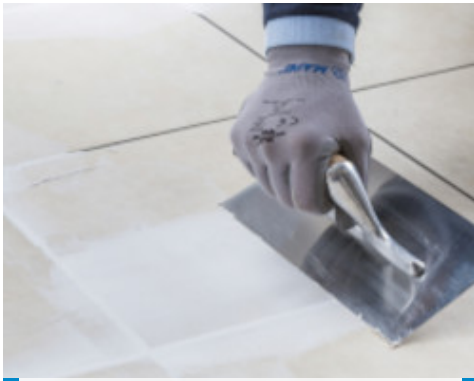
Wyrównywanie powierzchni płytek i wypełnianie spoin z użyciem Planiprep 4 LVT
