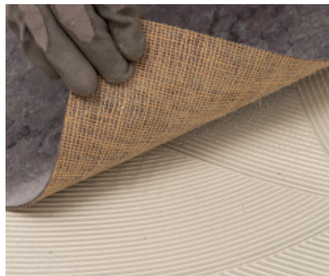
Montaż linoleum z użyciem Ultrabond Eco V4 Evolution
