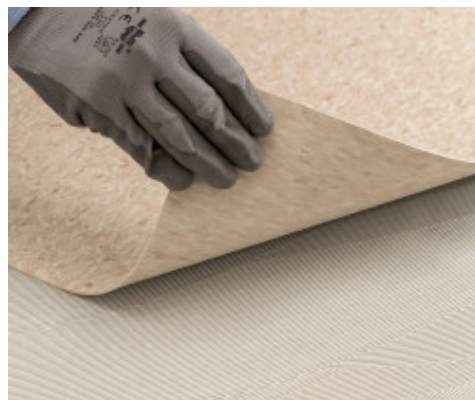
Montaż PVC homogenicznego z użyciem Ultrabond Eco V4 Evolution
