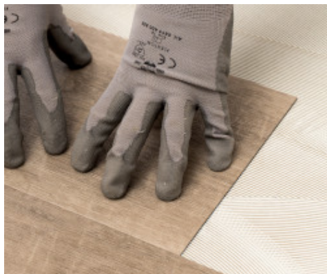
Montaż LVT z użyciem Ultrabond Eco V4 Evolution
