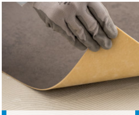
Montaż posadzki na bazie poliuretanu z użyciem Ultrabond Eco V4 Evolution
