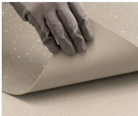
Montaż kauczuku z użyciem Ultrabond Eco V4 Evolution
