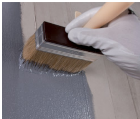
Nakładanie Eco Prim Grip Plus pędzlem na powierzchnię betonową
