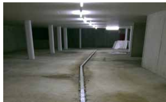
Przykład 2 Montaż w pozostawionym wgłębieniu
