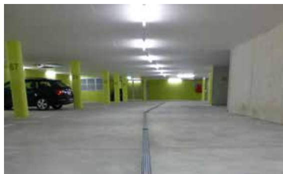
Przykład 2 Montaż w pozostawionym wgłębieniu
