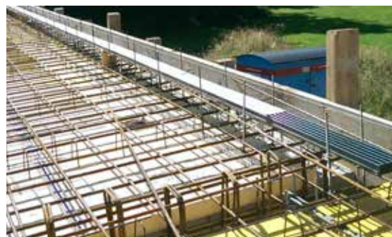
Przykład 1 Montaż na stojakach
