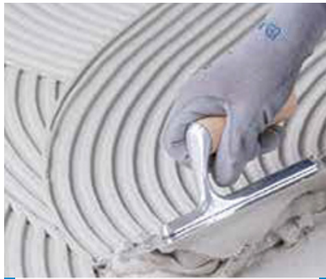
Rozprowadzanie Adesilex P9 w kolorze białym
