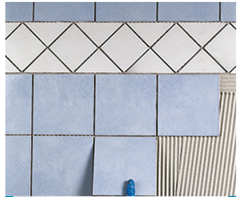
Montaż płytek typu monocottura na ścianie
