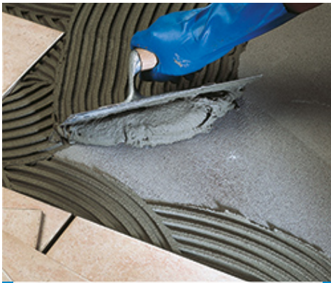
Montaż płytek typu monocottura na podłodze
