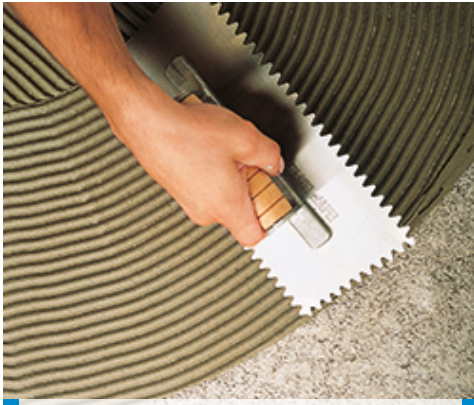
Rozprowadzanie Adesilex P9 w kolorze szarym
