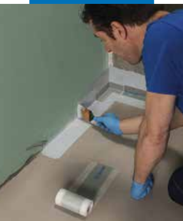
Przyklejanie taśmy Mapeband PE 120 na Mapegum WPS
