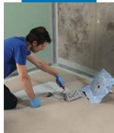
Montaż elementów Drain Vertical przy użyciu Mapegum WPS
