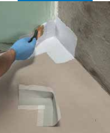
Przyklejanie narożnika Mapeband PE 120 na Mapegum WPS
