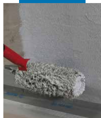
Nanoszenie warstwy Mapegum WPS wałkiem
