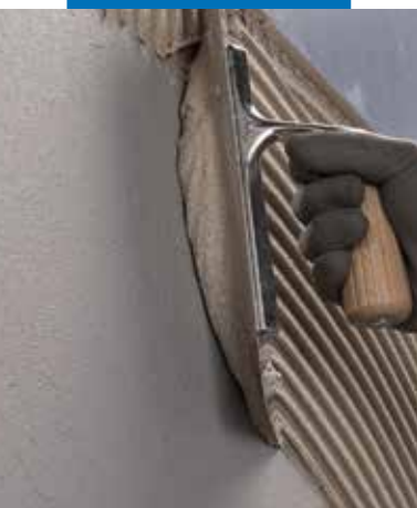
Montaż okładziny podłogowej przy użyciu zaprawy klejącej Keraflex Maxi S1
