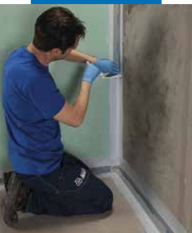
Przyklejanie taśmy Mapeband PE 120 na Mapegum WPS
