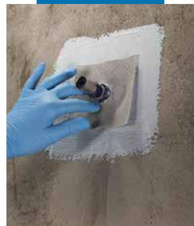
Montaż kawalki Mapeband PE 120 przy użyciu Mapegum WPS
